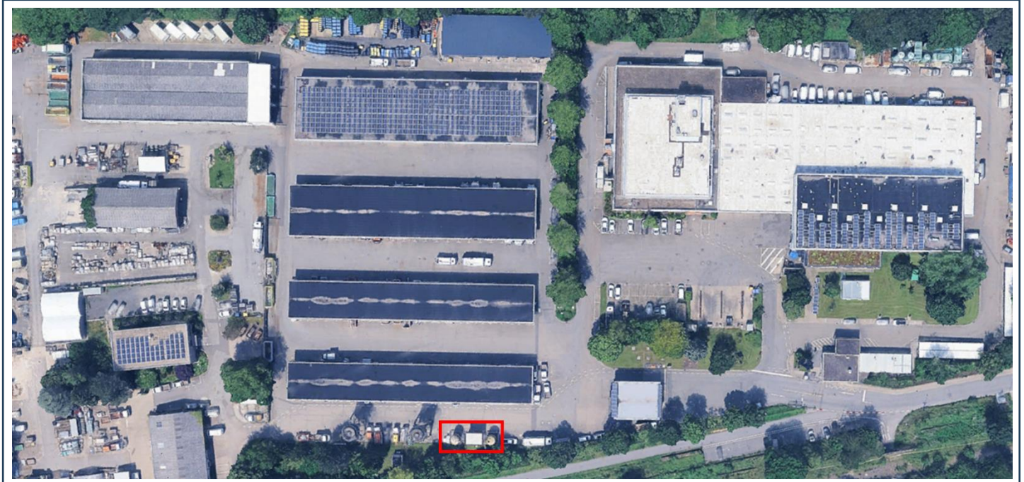
Abb. 1: Luftbild Zentralbetriebshof mit Standort der Altanlage
